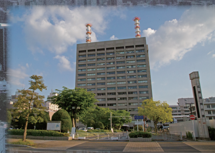
中国四国厚生局が入居する広島合同庁舎4号館
