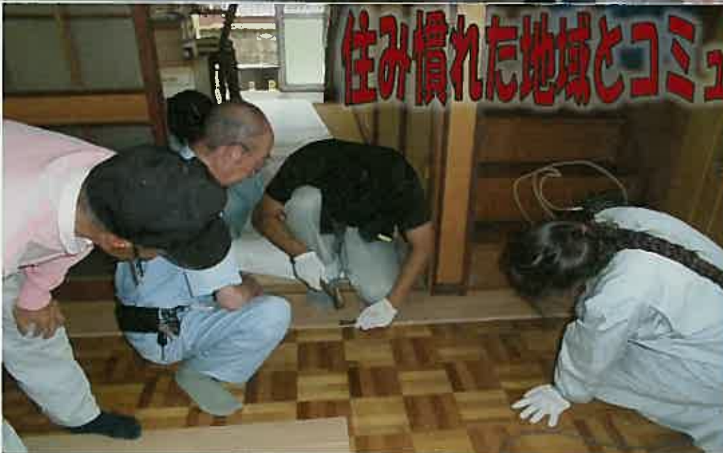
有明高専建築学科の学生による空き家改修工事
