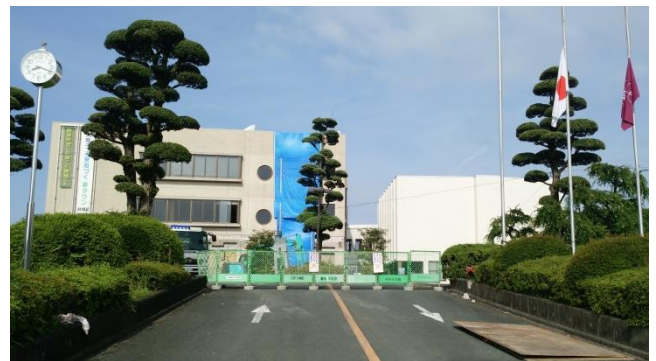
○益城町役場正面から撮影 (ブルーシート右横に見えるのが渡り廊下の位置)
