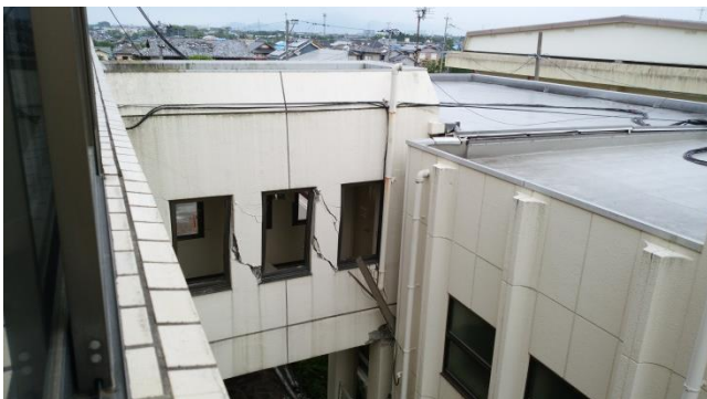
○物資班の後ろにある議会棟への渡り廊下
