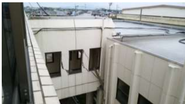
○物資班の後ろにある議会棟への渡り廊下
