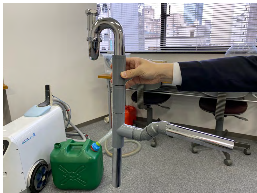
【給排水設備に接続する配管】
