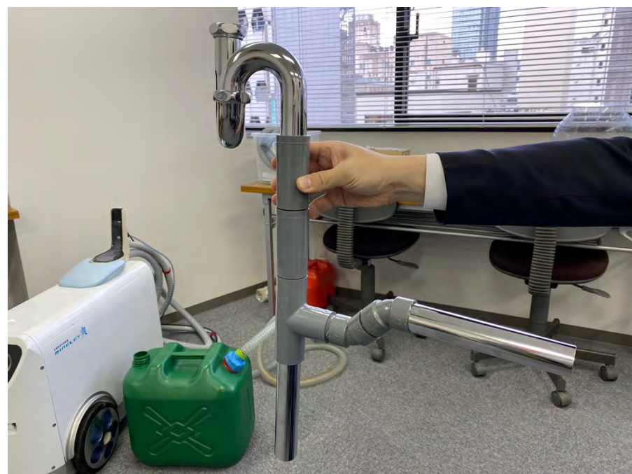
【給排水設備に接続する配管】
