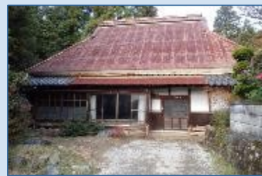
空き家の活用
