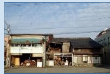
空き家の除却
