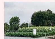
園地、園路整備
