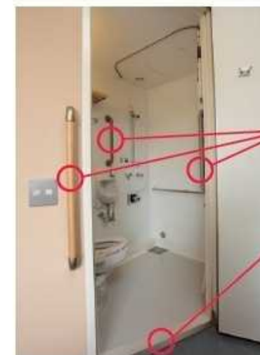
病室トイレへの手すり設置
