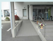
出入口の段差解消 事業費：30万円程度
