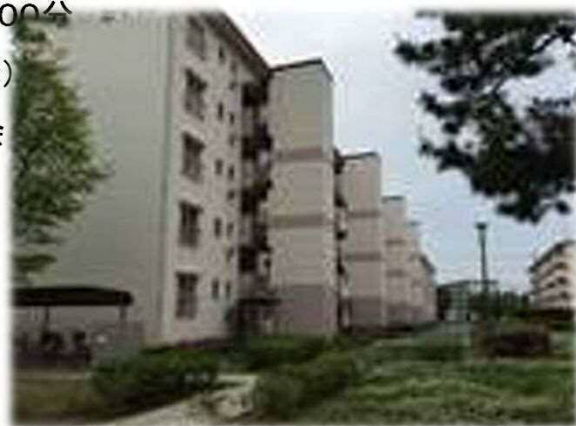
※外付けEVによるバリアフリー化
