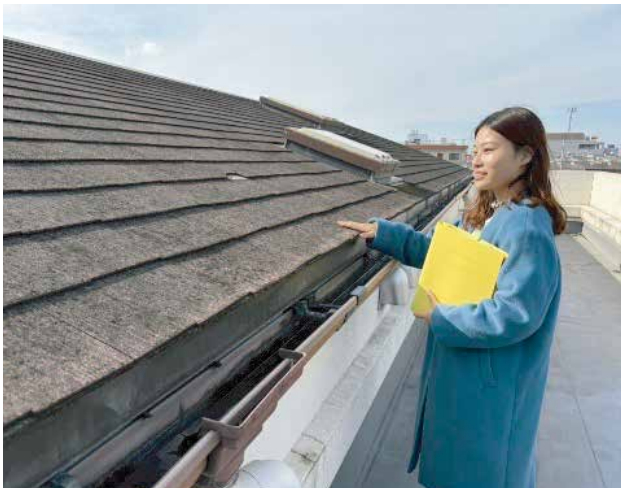
<災害補助金の被災施設(保育園)の実地調査>
