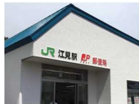
駅舎の 新改築・移設
