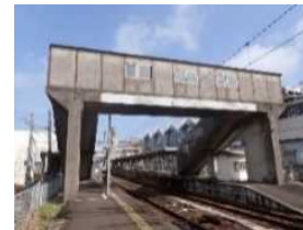
既存施設 の撤去
