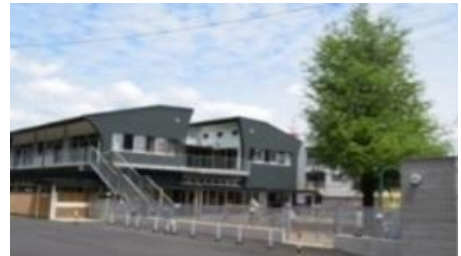
(写真) 保育所の整備(改修)
