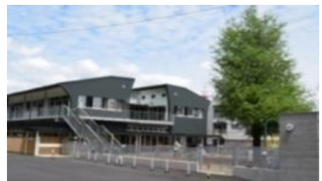
(写真) 保育所の整備(改修)
