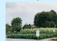
園地、園路整備
