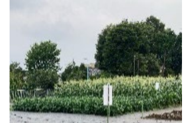
園地、園路整備
