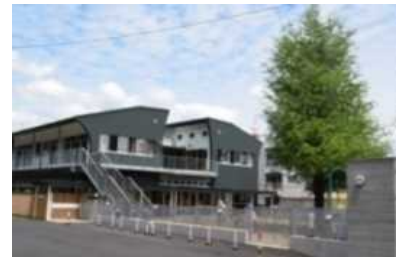
保育所の整備(改修)
