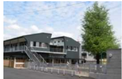
(写真) 保育所の整備(改修)
