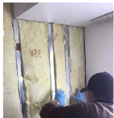
例：壁の防音改修
