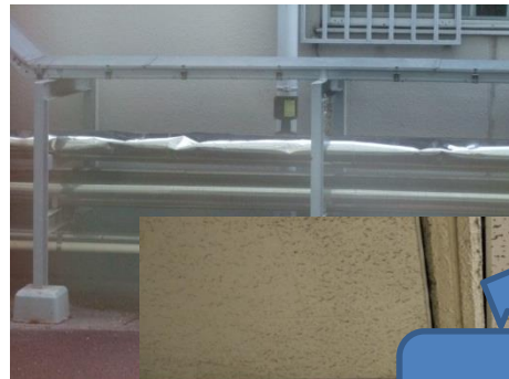
ボイラーパイプ 凸凹
