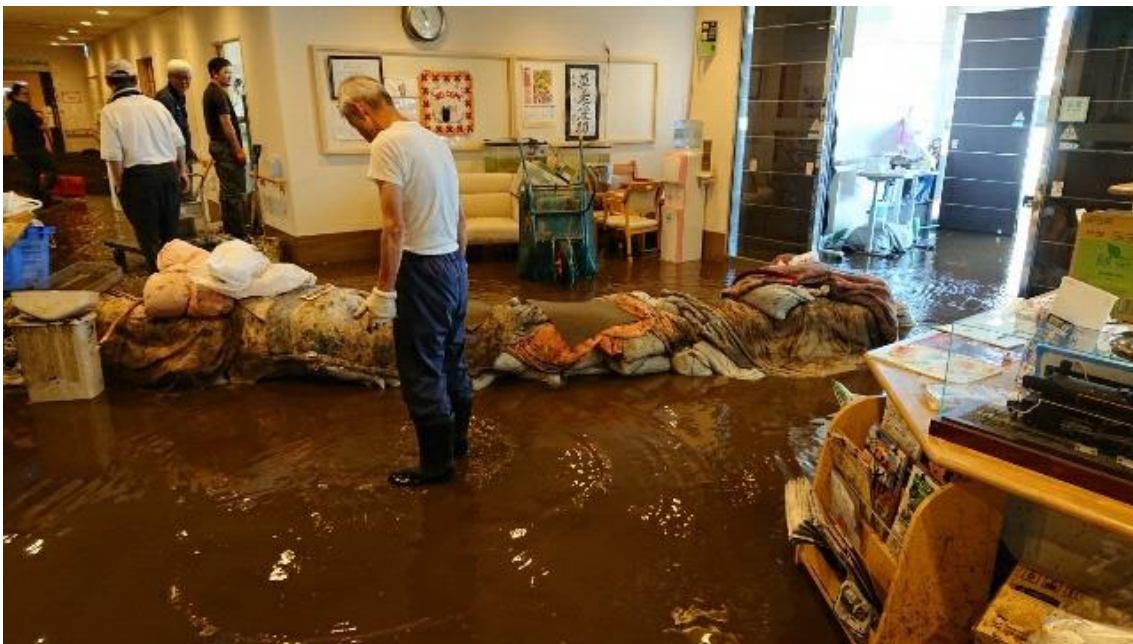
台風による老人福祉施設の被害
