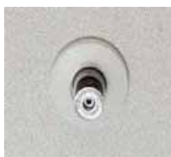
スプリンクラー設備
