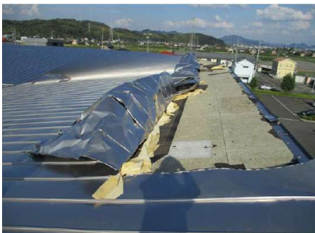
老人福祉施設の台風による被害
