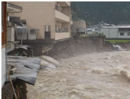
保健センターの豪雨による被害
